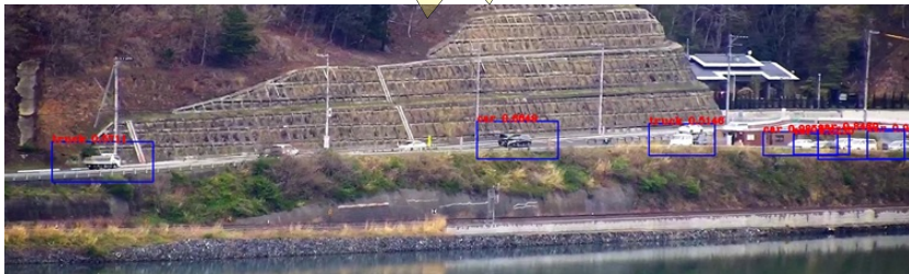
宮城県女川町における 国道渋滞状況モニタリング
