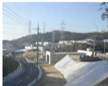
新生駒変電所付近の工事状況
