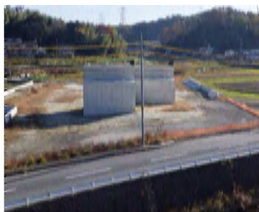
国道163号を跨ぐ橋梁の工事状況
